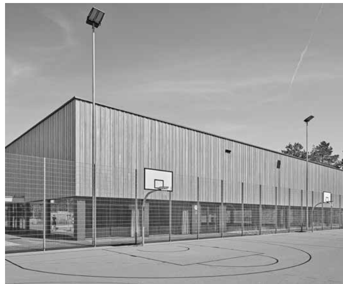
Dreifachturnhalle mit Allwetterplatz Süd (Bilder: Roger Frei, Zürich)
