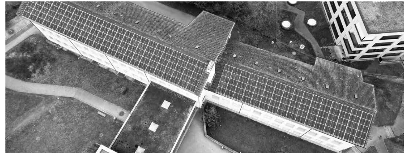
195 Solarpanels wurden auf dem Dach der Schulanlage Schützenmatt verlegt.
