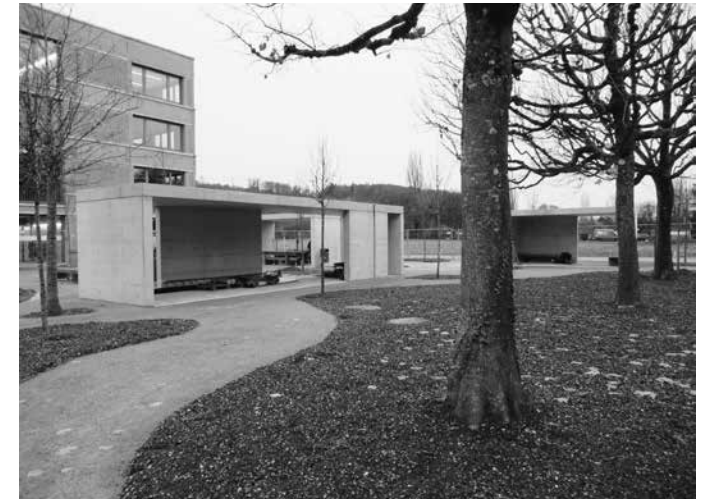
Nebenbauten vor dem Erweiterungsbau des Bildungszentrums Fricktal (BZF)
