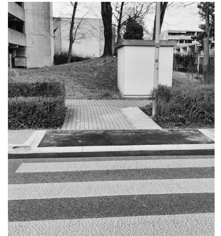
Waldhofstrasse; Schutzvorbauten bei der Fussgängerüberquerung
