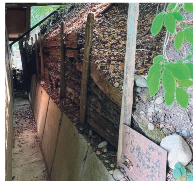
Stützmauer hinter der Hütte
