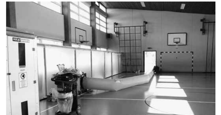
Unterdruckzone für die Asbestsanierung in der Turnhalle Robersten
