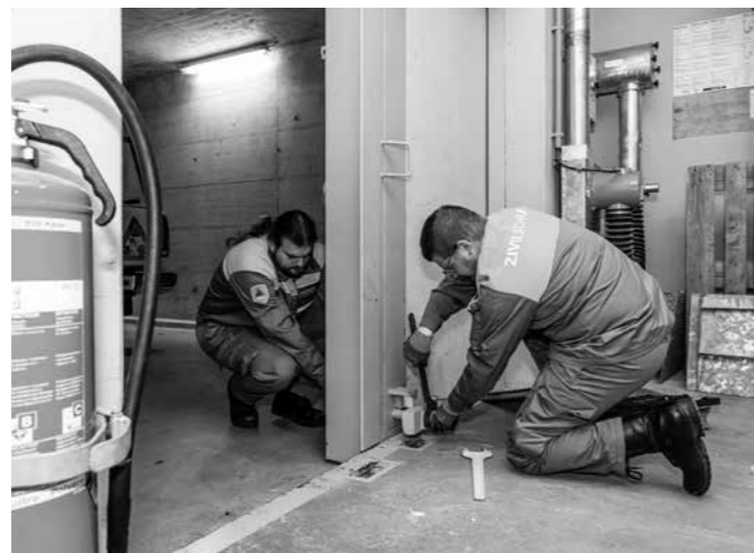
Angehörige des Zivilschutzes bei den Unterhaltsarbeiten an Anlagen
