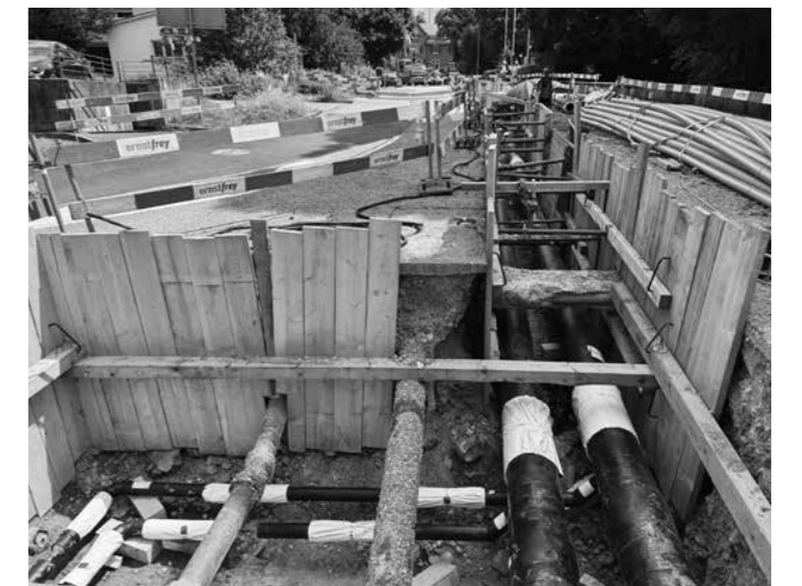
Einbau Fernwärmeleitung in der Roberstenstrasse
