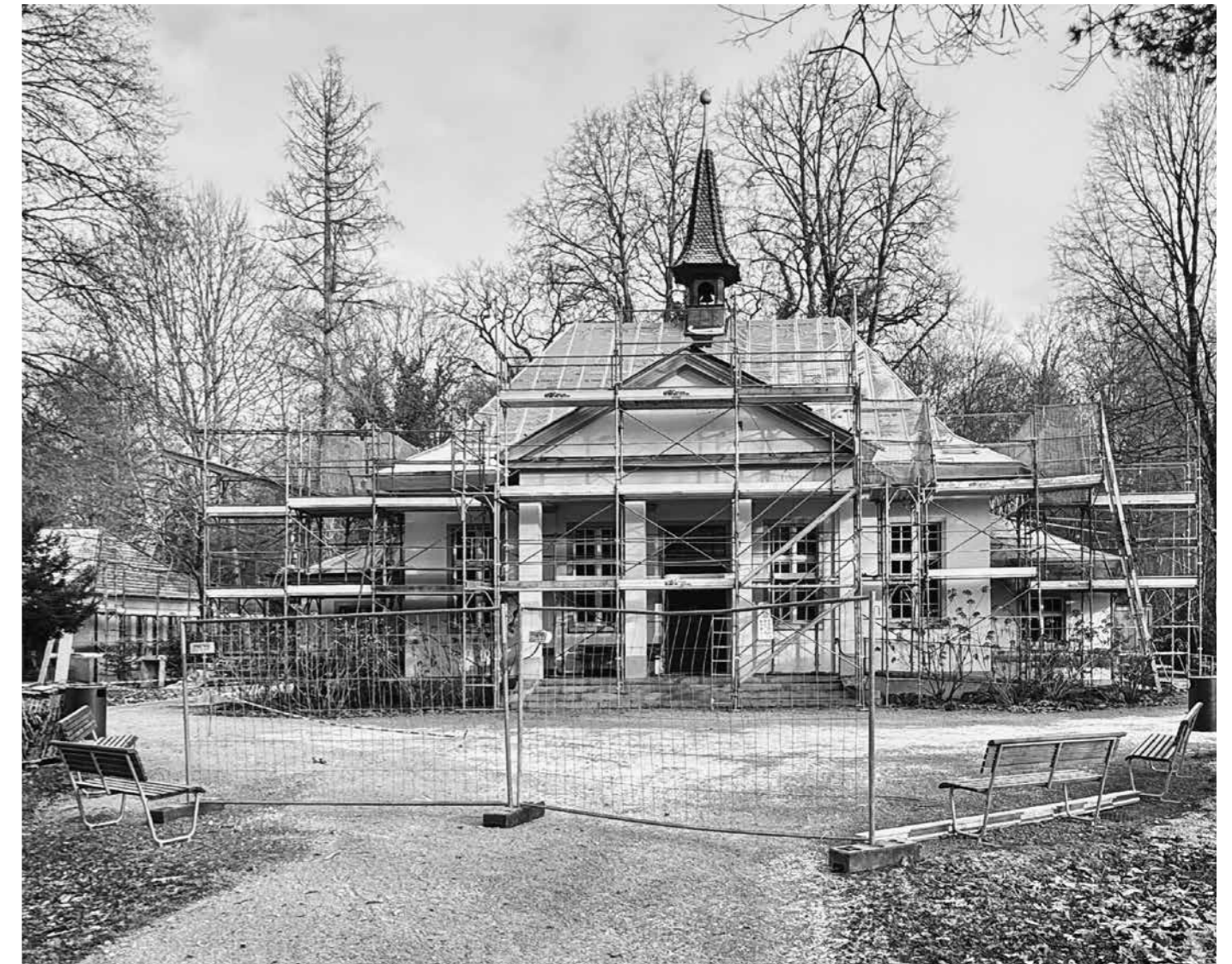
Die Sanierungsarbeiten an der Kapelle auf dem Waldfriedhof schreiten voran.
