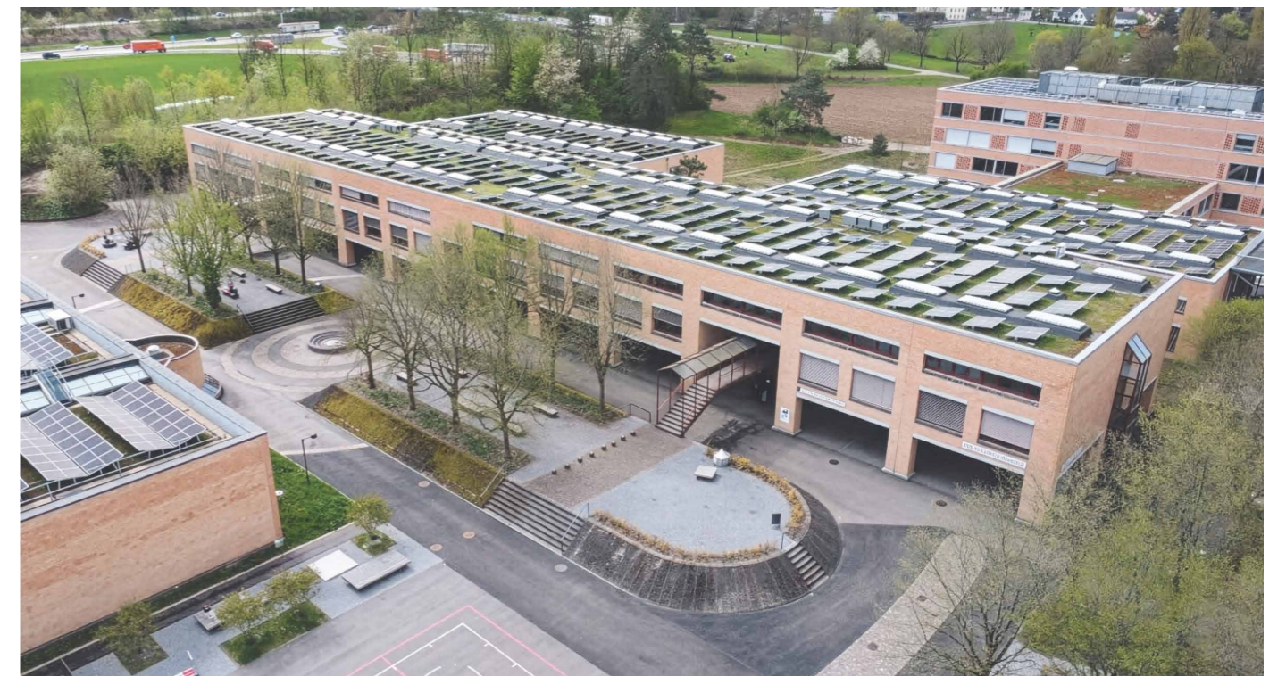
Die im Jahr 1982 in Betrieb genommene Schulanlage Engerfeld bedarf einer Sanierung von Flachdach und Gebäudehülle.
