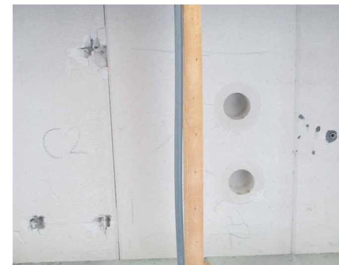
Untersicht an Siporex-Dach-Tragplatten
