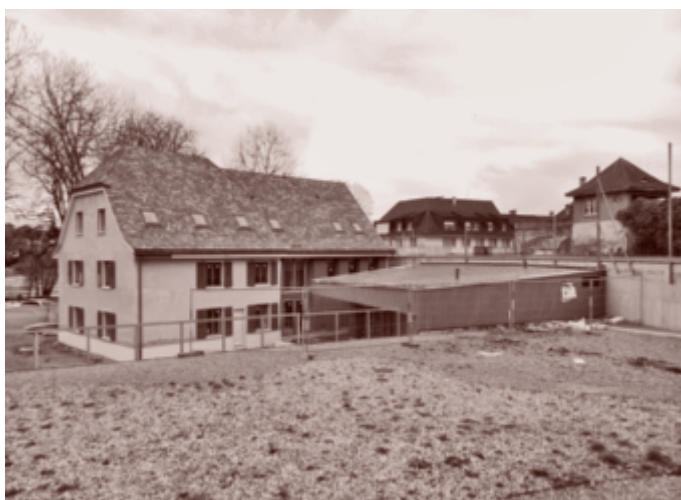
Rotes Haus mit neuem Anbau an der Schiffflände
