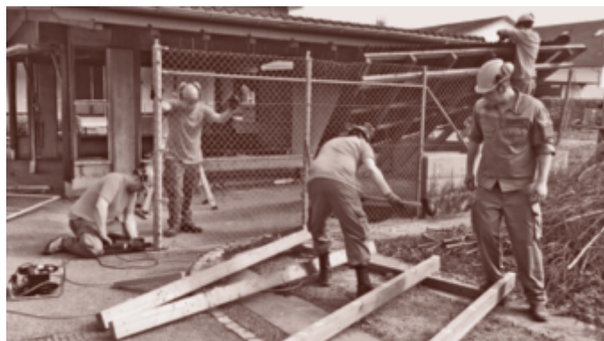
Rückbau eines Gebäudes bei der MBF in Stein
