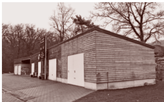
Anbau Geräteraum / Garderobe beim Sportplatz Schiffacker
