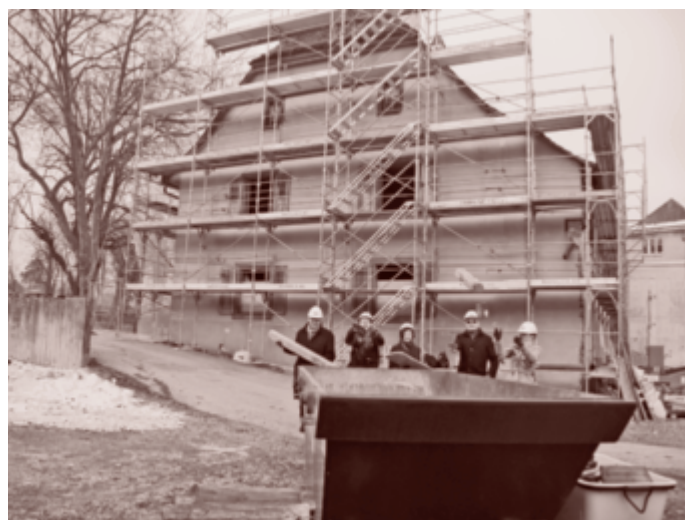
«Spatenstich» für das Rote Haus: Der Gemeinderat legt selber Hand an.
