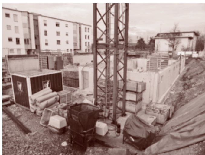
Gebäudeabbruch Töpferweg, ehem. Buchbinderei Schaffner und Neubau Mehrfamilienhäuser Töpferweg
