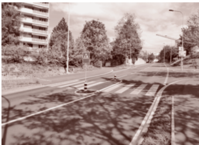
Die für FussgängerInnen und Radfahrende neue sichere Strassenquerung in der Zürcherstrasse
