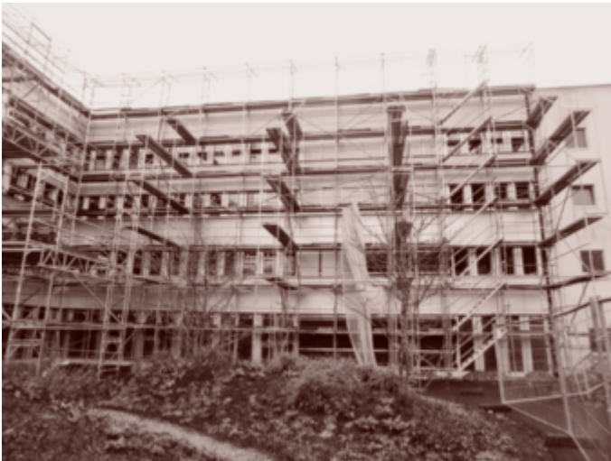
REHA-Klinik mit Spezialgerüst, freistehend ohne Fassadenanker
