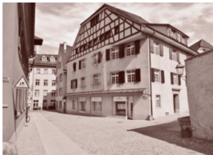
Neue Pflasterung in der Kirchgasse
