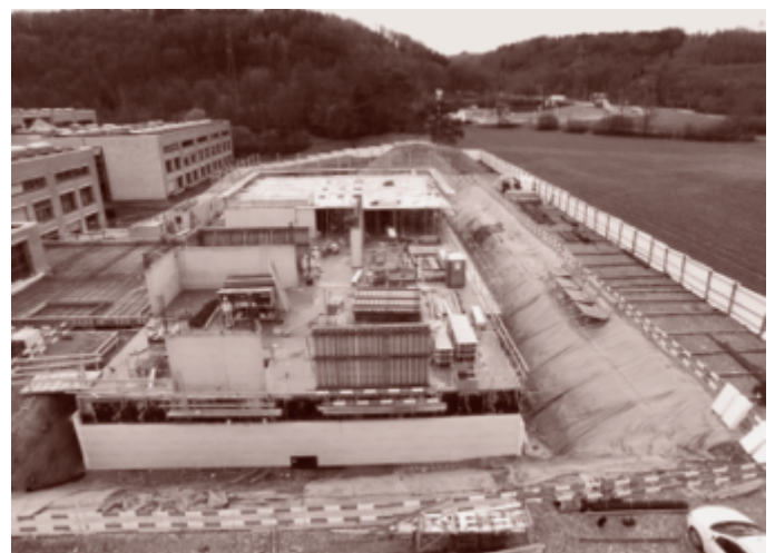
Baustelle Schulanlage Engerfeld Dezember 2017
