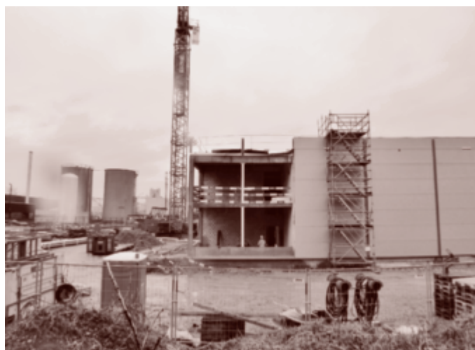
Die SwissShrimp-Produktionshalle in der Ausführungsphase
