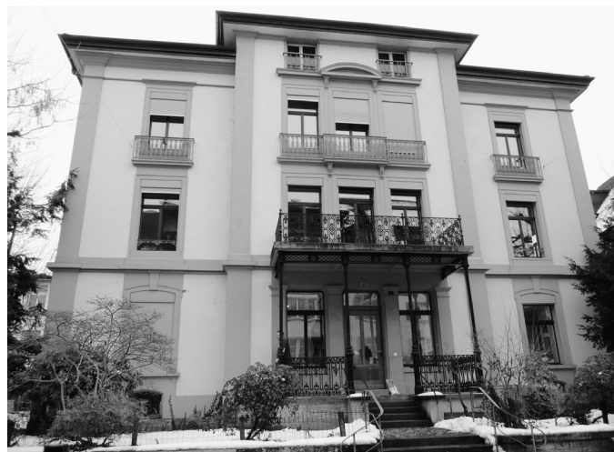
Aussenansicht Marktgasse 1 nach Sanierung
