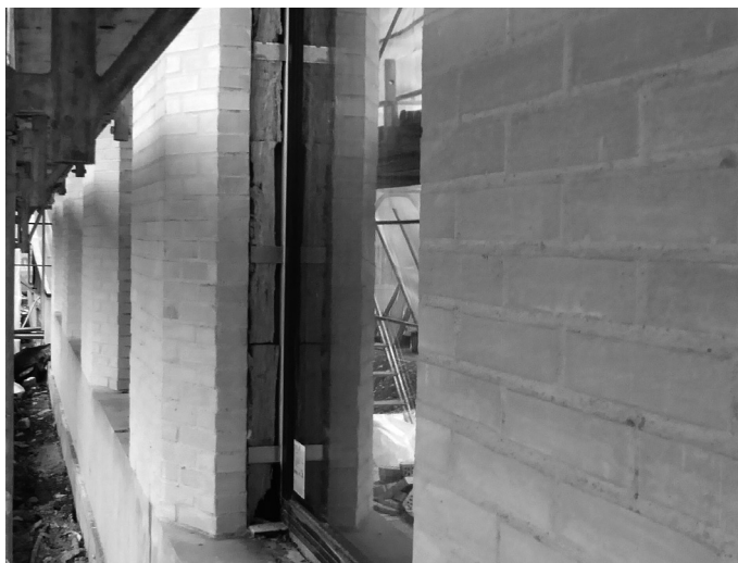
Sichtmauerwerk Neubauprojekt «Kaiserstrasse»
