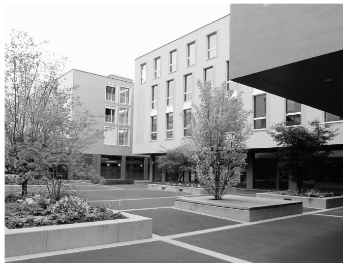
Überbauung Salmenpark 1. Etappe; Bauabnahme
